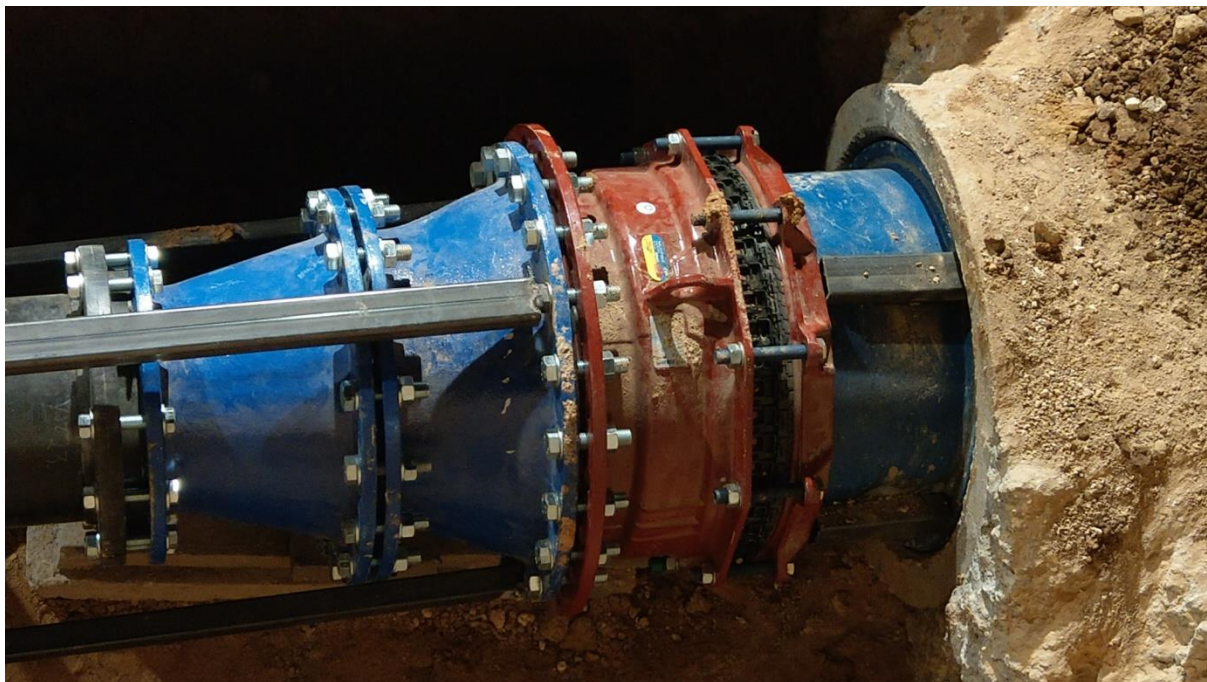
A befűzött csőszakasz csatlakozása
