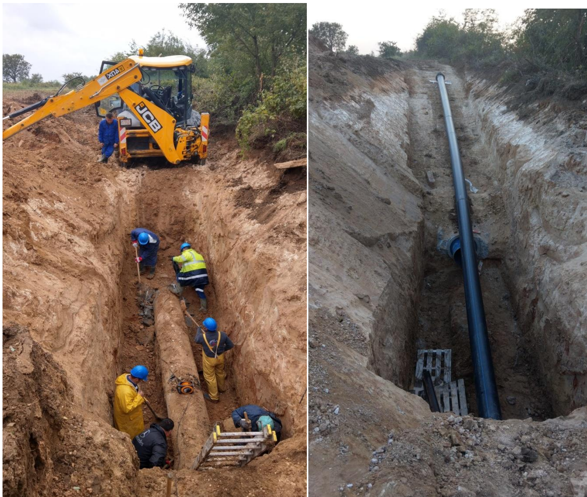
A földmunka és a csőkígyó betolása
